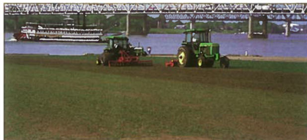
Installation d'un système de couverture de sable pour une aire gazonnée de stationnement et de rassemblement, Louisville Waterfront Park
