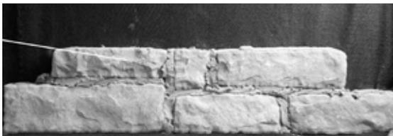
Mettez les pierres de niveau inégal à niveau en utilisant une autre petite pierre sur le dessus pour obtenir la hauteur désirée et un niveau égal. Lorsque vous utilisez des pierres, utilisez une deuxième pierre de petite taille pour obtenir la hauteur désirée.
