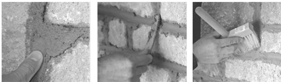
Laissez sécher les joints de mortier jusqu'à ce que l'empreinte de votre pouce ne soit plus visible, puis utilisez les outils de votre choix (Joints concaves, lissés, raclés). Passez une balayette sur le mur pour nettoyer les joints.
