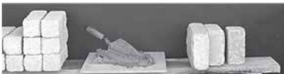
Placez les pierres plus petites de 6 po le long du support du mur en les alternant avec des pierres de 12 po.
