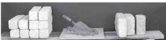
Placez les petites pierres de 4 po le long du support du mur en vous assurant d'utiliser deux fois plus de pierres de 4 po que de pierres de 8 po. Étalez les pierres de 8 po de la couche supérieure le long du support du mur, selon les besoins.
