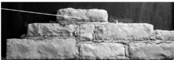
Les joints de tête doivent être décalés d'au moins 2 po ; essayez de ne pas aligner plus de trois joints verticaux.
