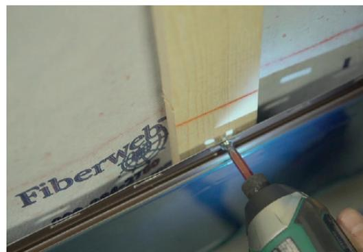
Advenant le cas où une fourrure n'est pas alignée, nous recommandons de laisser un jeu entre le mur ou la fourrure et le parement d'acier lorsque la vis y est fixée dans le but d'éviter de créer une trop grande tension sur le produit, ce qui pourrait entraîner un effet de voilement.
