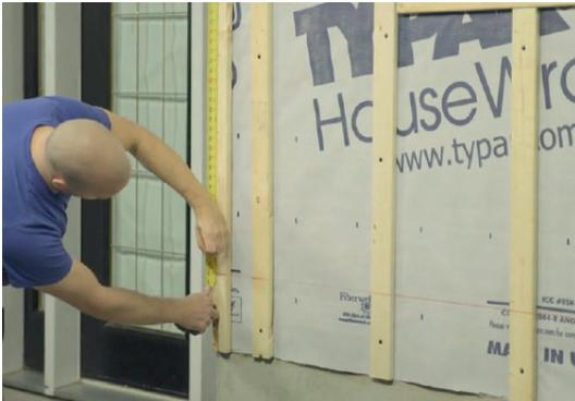
Fixer maintenant en place la moulure de départ, #M10SHWP, à 3 po au-dessus de l'endroit où vous débuterez votre mur. Utilisez selon le besoin des vis à bois MAC anticorrosion ou des vis auto perçantes MAC anticorrosion 1 1/8 ou 2 1/2 po. Sécurisez-la à l'aide d'une première vis. Lorsque vous serez à niveau, vissez-la en place. Sécurisez-la à l'aide d'une première vis. Lorsque vous serez satisfait de l'alignement, vissez-la en place.
