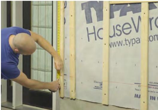
Fixer maintenant en place la bande de départ, No. M10D, à 3'' au-dessus de l'endroit où vous débuterez votre mur. Utilisez selon le besoin des vis MAC 1/2'' à tête plate pour le métal ou des vis MAC à bois de 1 1/8'' à tête plate. Sécurisez-la à l'aide d'une première vis. Lorsque vous serez à niveau, vissez-la en place.
