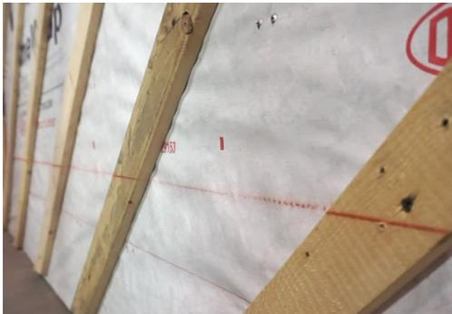
Fixez maintenant en place la bande de départ #M10D à 3 po au-dessus de l'endroit où vous débutez votre mur. Utilisez selon le besoin des vis à bois MAC anticorrosion ou des vis autoperçantes MAC anticorrosion 1 1/8 ou 2 1/2 po. Sécurisez-la à l'aide d'une première vis. Lorsque vous serez à niveau, vissez-la en place.
